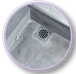
地台去水位有否阻塞； 去水位的鐵柵有否銹蝕
