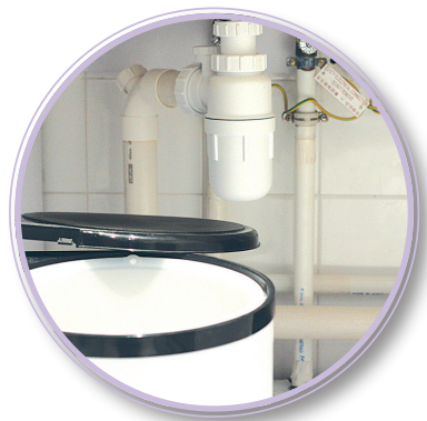
廚房星盆、洗衣機、地台去水口的 隔氣管和喉管有否阻塞或漏水
