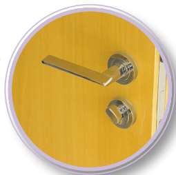
檢查門鎖 / 把手一能否正常運作，有否脫色，或零件有否鬆脫
